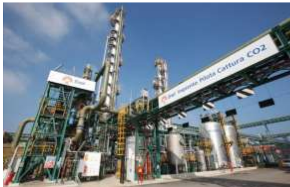
Завод за улавяне на CO в електроцентрала на въглища с мощност 2 600 MW Brindisi Sud, управлявана от ENEL в Италия
